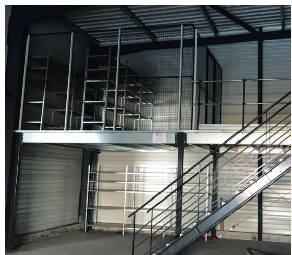
De stellingen van OMNITIV XL worden afgebakend door industriële verdelingen. toegankelijk op een platform STOCK.
